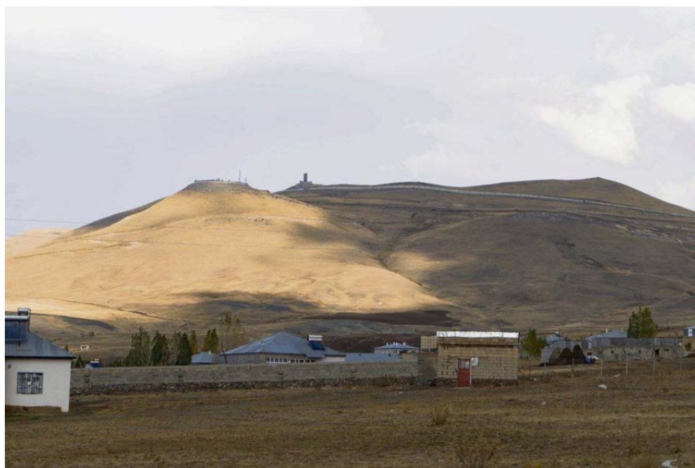
Des fossés ont été creusés dans la montagne et de nouvelles routes construites pour permettre l'acheminement des matériaux nécessaires à l'érection du mur, privant les villageois de leurs terres. © Angeline Desdevises
